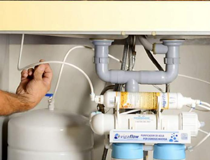
La función principal del **Purificador de Agua Osmosis Inversa de Vigaflow** es mejorar la calidad y sabor del agua en tu hogar, empresa u oficina. Este aparato elimina significativamente sedimentos, virus, bacterias, pesticidas e impurezas.
