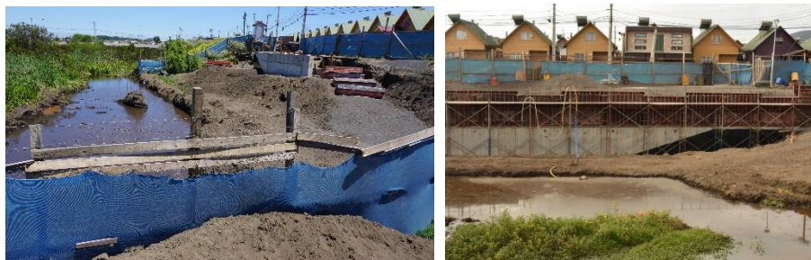
Figura 40. Registro fotográfico de relleno de humedales en sistema humedal Calabozo y Quiñenco
