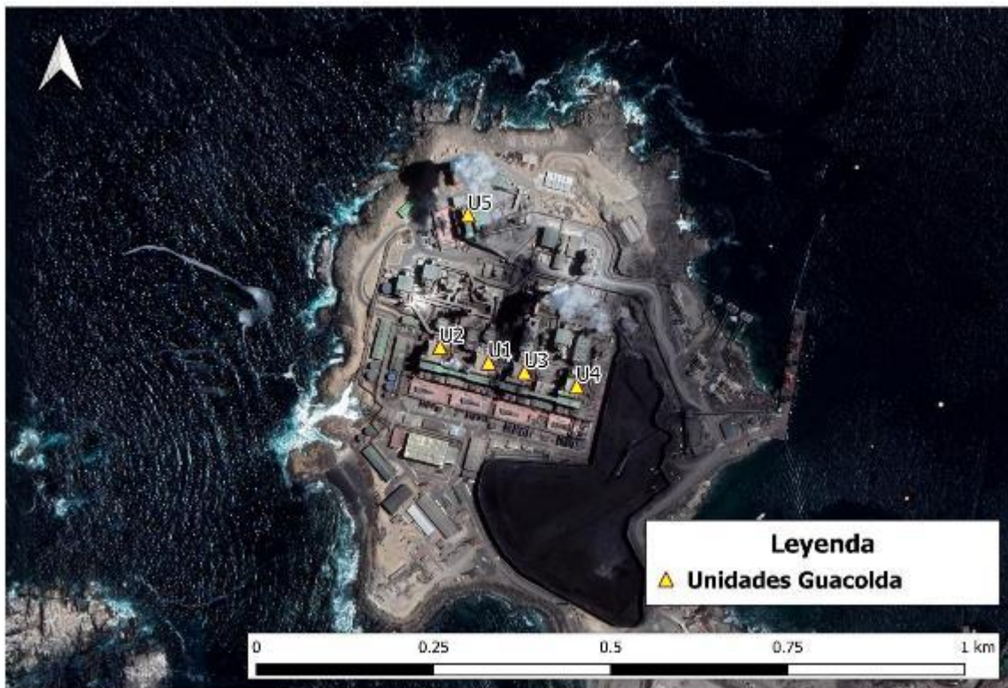
Figura 115 – Ubicación Unidades generadoras de Guacolda
