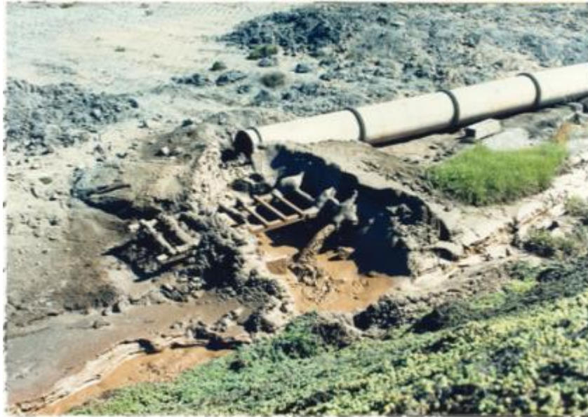
Figura 111 – Relaveducto histórico de CMP
